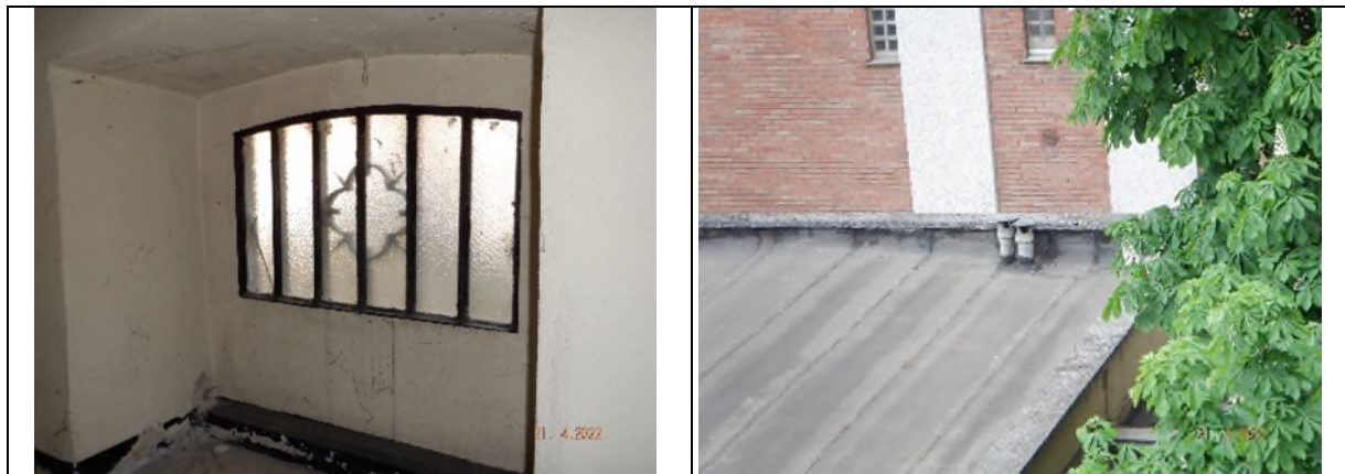
Al piano terra sul vano scale del lato infanzia lo stucco della finestra bassa contiene amianto
