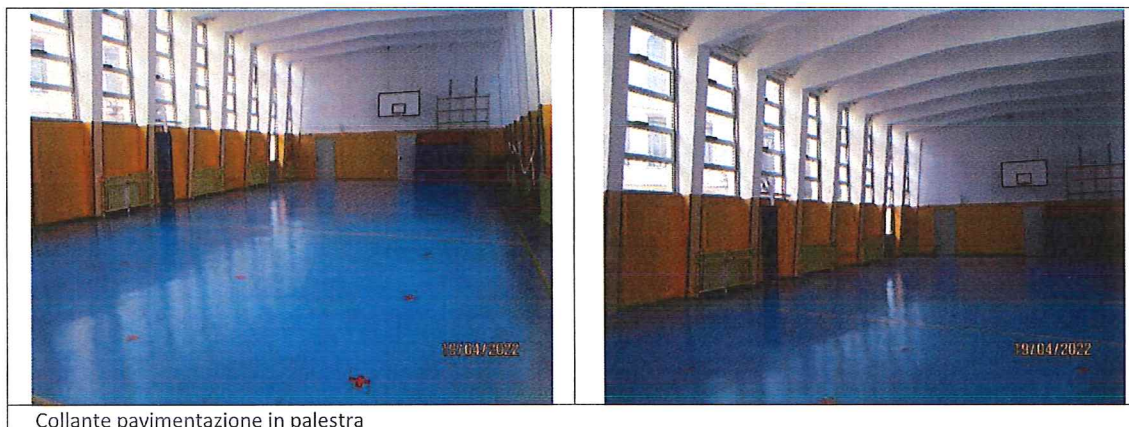
Collante pavimentazione in palestra
